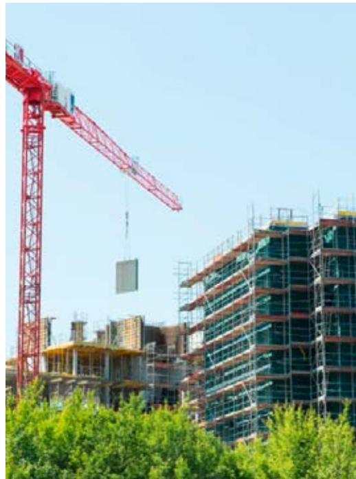
Mehrgeschossiges Wohnhaus in Schottenbauweise an der Spree in Berlin.
